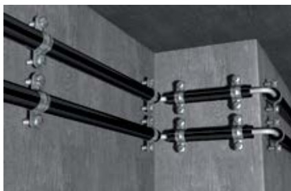
Крепление стальных трубопроводов в защитной оболочке
