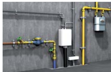
Крепление трубопроводов
