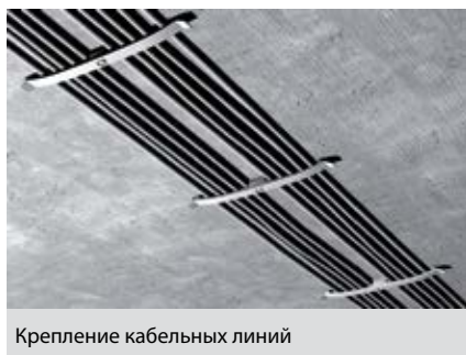
Крепление кабельных линий
