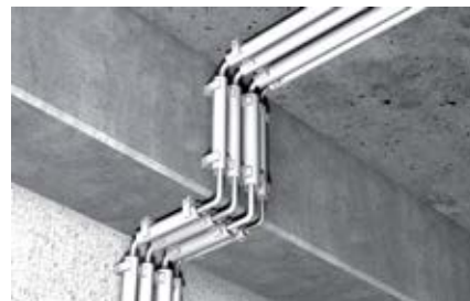
Крепление пластмассовых изоляционных труб
