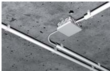
Крепление пластмассовых изоляционных труб
