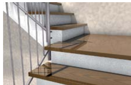
Лестничные ступени на бетонных лестничных балках
