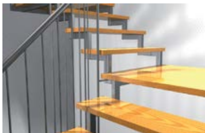
Лестничные ступени на стальных лестничных балках
