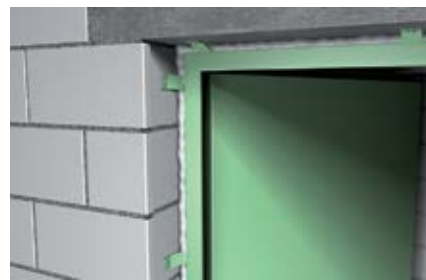
Герметизация стальных дверных коробок
