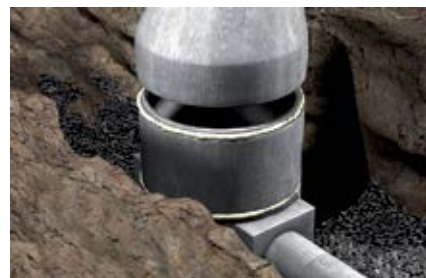
Герметизация бетонных колец канализационных колодцев
