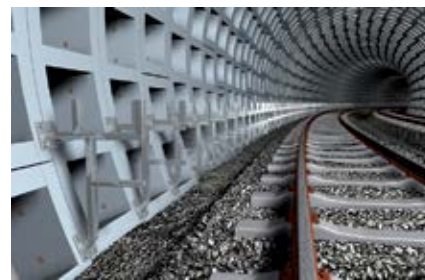
Монтаж в туннелях
