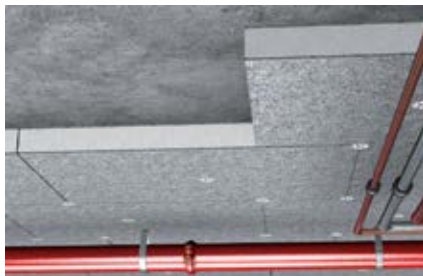
Прочные на сжатие изоляционные материалы при креплении к потолку
