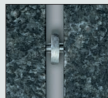
Вид обычного соединения типа dowel
