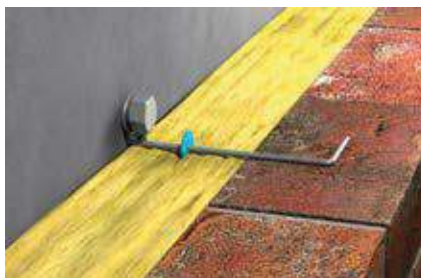
Фасадная кирпичная кладка
