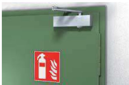
Швы вокруг огнеупорных дверей
