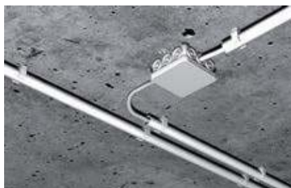
Крепление пластмассовых изоляционных труб
