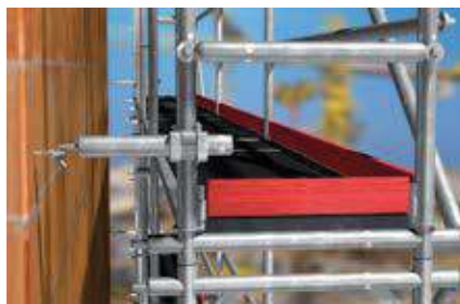
Крепление строительных лесов
