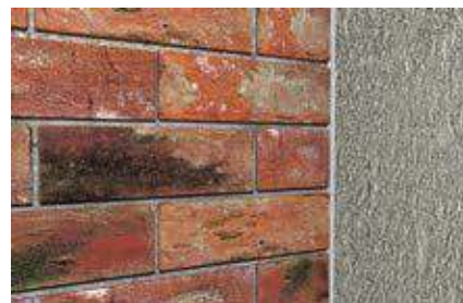
Швы между зданиями
