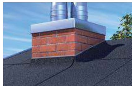
Герметизация кровли с применением листового битума
