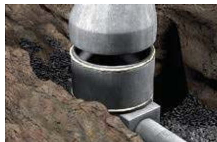
Герметизация бетонных колец канализационных колодцев
