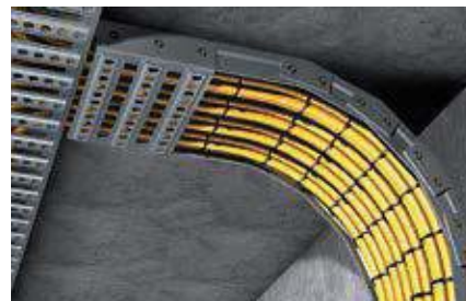
Связывание электрических кабелей
