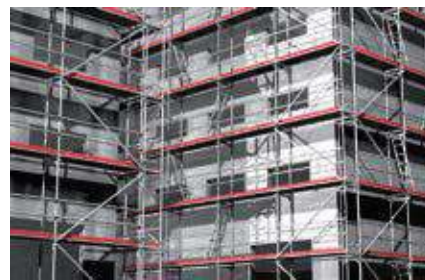
Фасадные строительные леса
