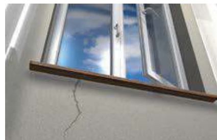
Заделка внутренних трещин в кирпичной кладке
