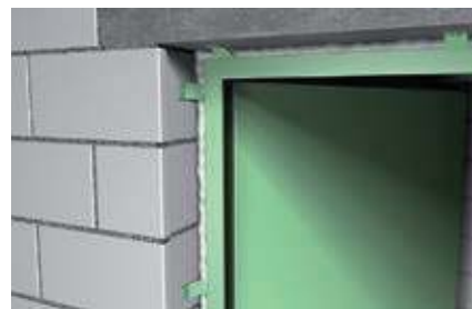
Герметизация стальных дверных коробок
