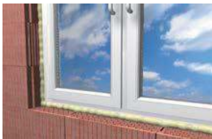
Швы оконных соединений
