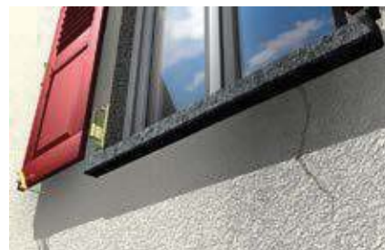
Заделка наружных трещин в кирпичной кладке
