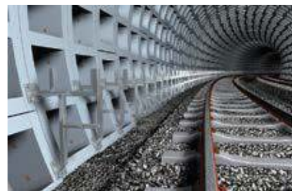
Монтаж в туннелях
