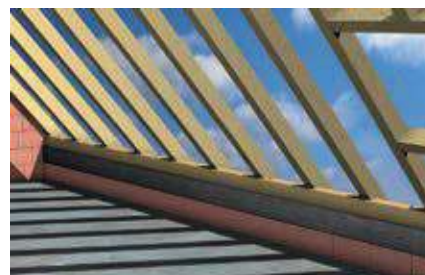
Крепление кровельной обрешетки
