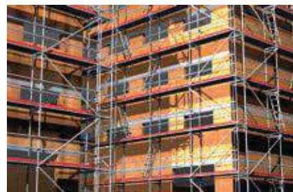
Фасадные строительные леса
