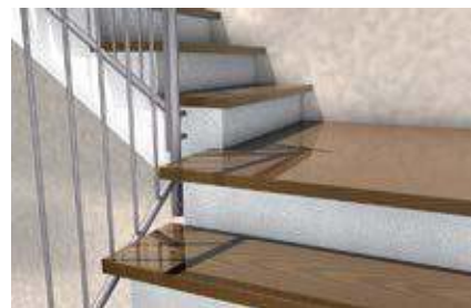
Лестничные ступени на бетонных лестничных балках
