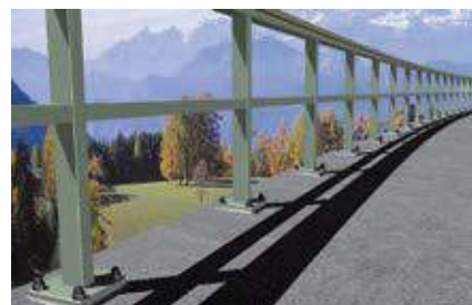
Перильные ограждения мостов
