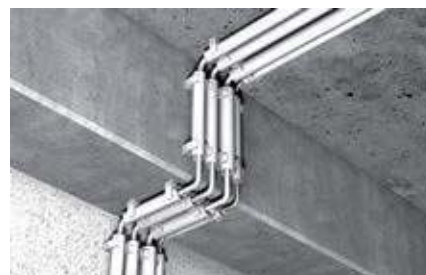
Крепление пластмассовых изоляционных труб
