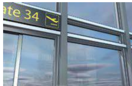
Герметизация в общественных зданиях
