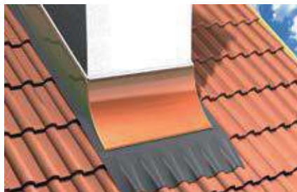
Герметизация фартуков вокруг дымоходов
