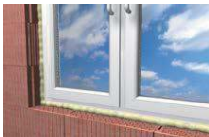
Швы оконных соединений
