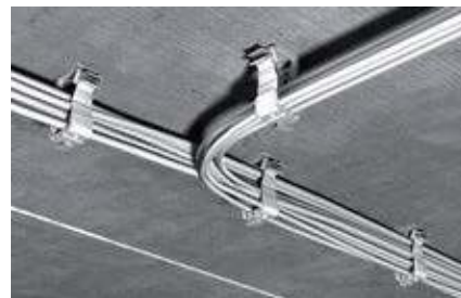
Крепление пучков кабелей
