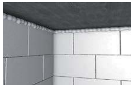
Заделка швов при строительных работах
