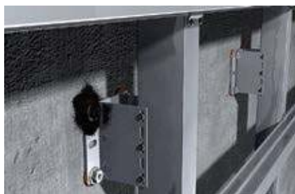
Герметизация головок шурупов
