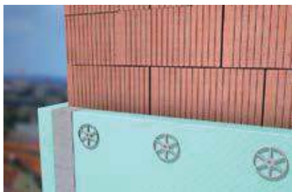
Заполнение полостей в изоляции
