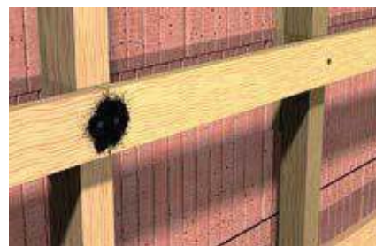
Герметизация головок шурупов
